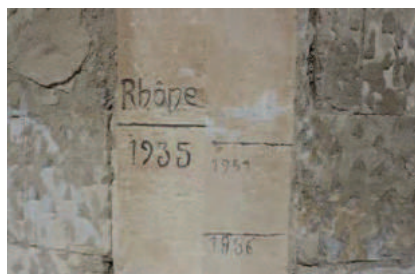
Repères de crue sur une maison de Boulbon (Source : Élaboration des Plans de Prévention des Risques Inondation (PPRi) du Rhône, Rapport du CGEDD n° 008677-01, 2013)
