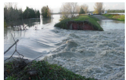
Brèche dans les digues de protection du trémie ferroviaire à Tarascon en 2003 (Source : SYMADREM)
