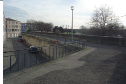
Quai de Tarascon avant travaux (Source : SYMADREM)
