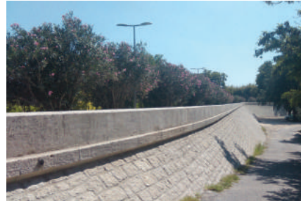
Quai de Tarascon après travaux (Source : SYMADREM)
