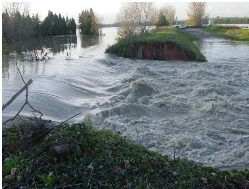
Figure 16 : Brèche dans les digues de protection des trémies ferroviaires (Source : SYMADREM)
