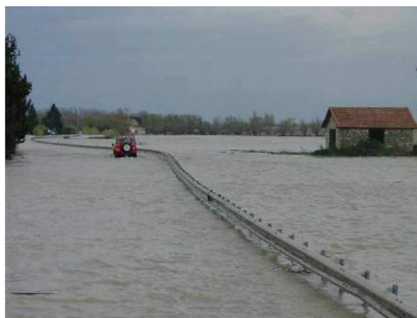
Figure 7 : Route de Tarascon à Arles le 4 décembre 2003
