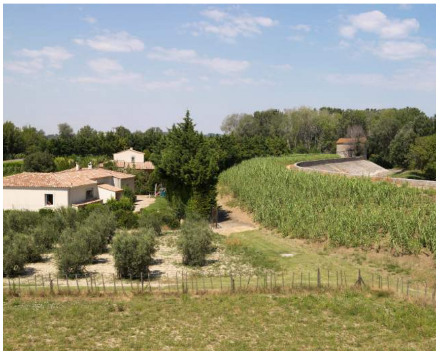
Figure 20 : Habitations à l'arrière de la digue de la Montagnette (Crédit photo : Bertrand Stofleth)
