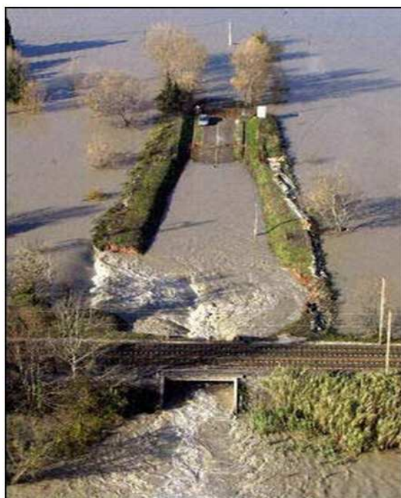
Figure 11 : Rupture des cavaliers de protection de la trémie en 2003
