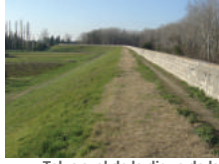
Talus aval de la digue de la Montagnette (Source : SYMADREM)
