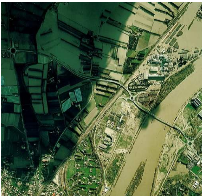
Figure 8: Inondation de la zone du Radoub à Tarascon en décembre 2003 (Source : Mairie de Tarascon)
