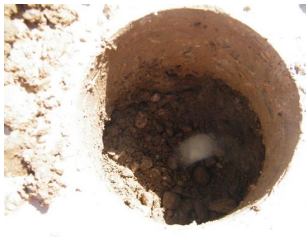
Vue du matériau sous la dalle
