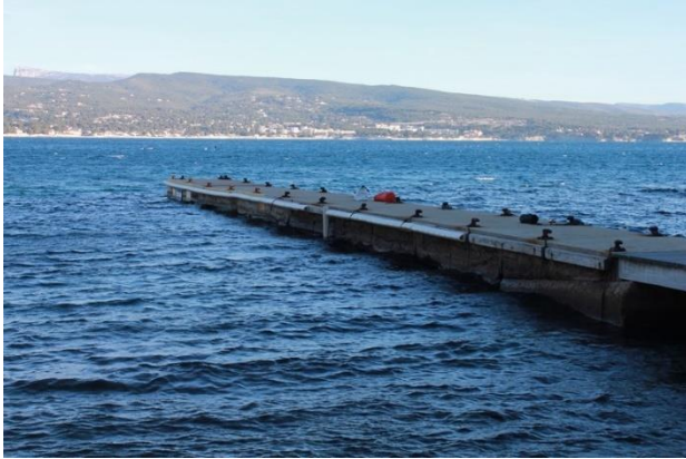
Vue générale du ponton (photo prise côté Ouest de la calanque)
