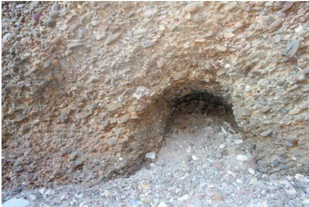
Vue de la cavité dans le renforcement
