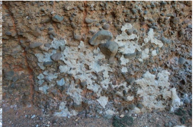
Trace d'enduit ancien dans le renforcement (ancien bâtiment ?)
