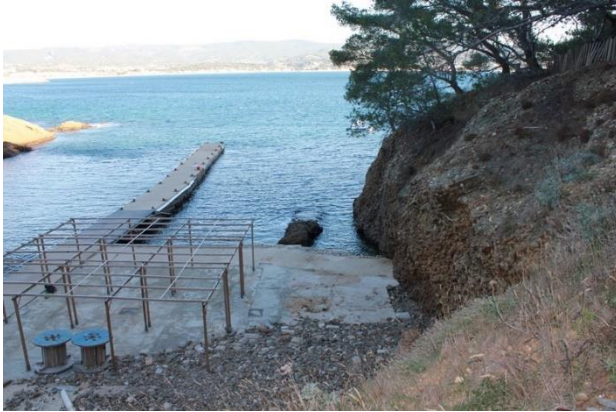
Vue générale de la calanque côté Est
