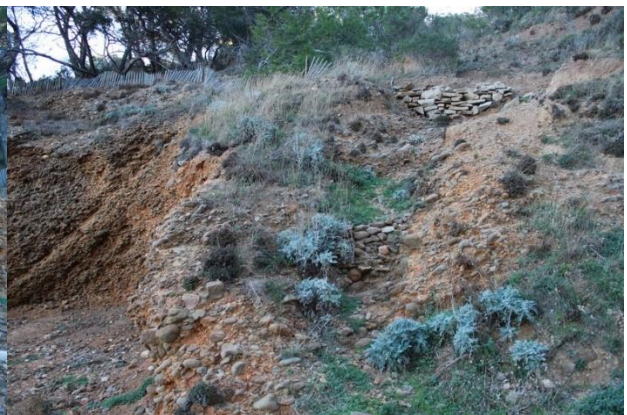
Vue arrière du renforcement Est
