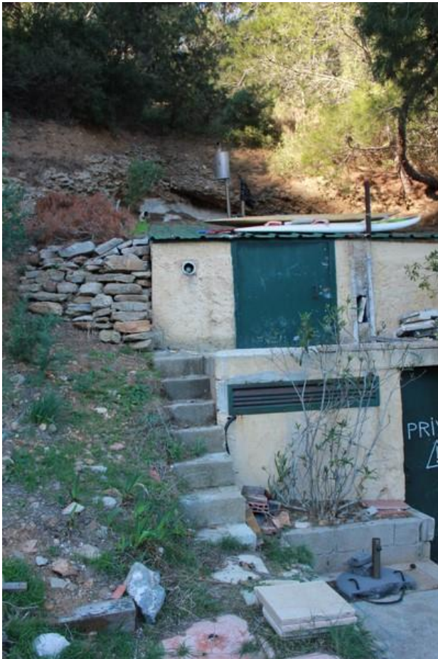
Vue de la remise creusée dans le poudingue
