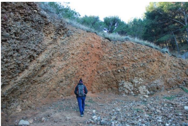
Vue du renforcement côté Est
