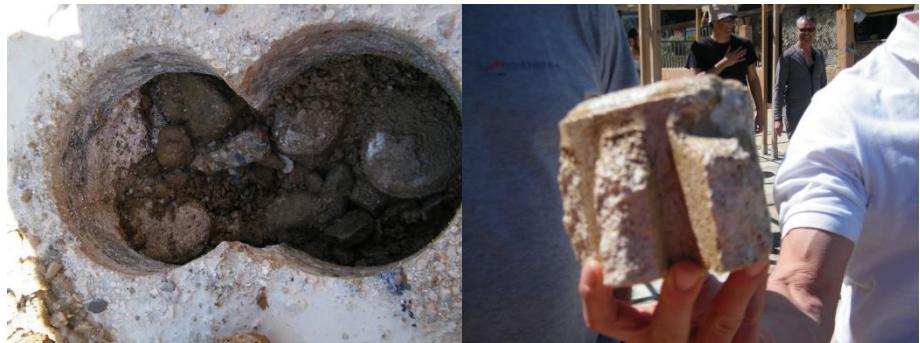
Vue du matériau avec en haut à droite les pavés en pierre reconstituée
