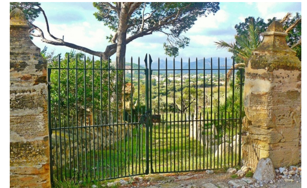
Les portails fermés bloquent l'accès à l'habitation au SDIS
