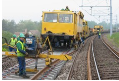
Longs Rails soudés sur traverses béton
