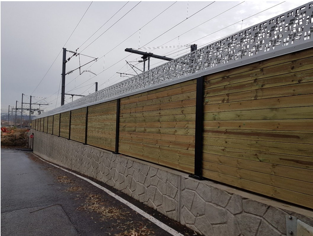
Photo de l'écran acoustique réalisé boulevard Netty à Marseille
