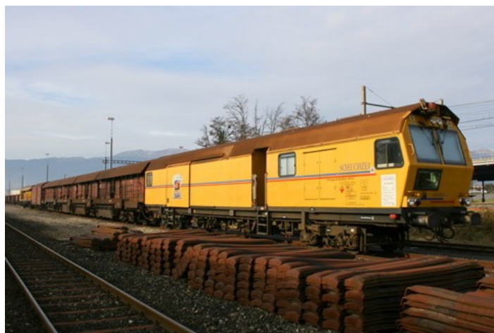
Train meuleur de rails (Scheuchzer S.A.)
