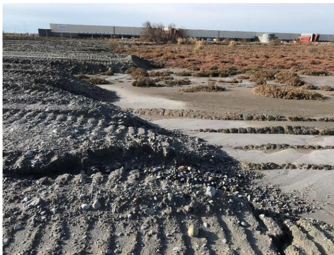
Limite entre les zones terrassées et la sansouïre J. VIGLIONE, 11/01/2018, Port-Saint Louis (13)
