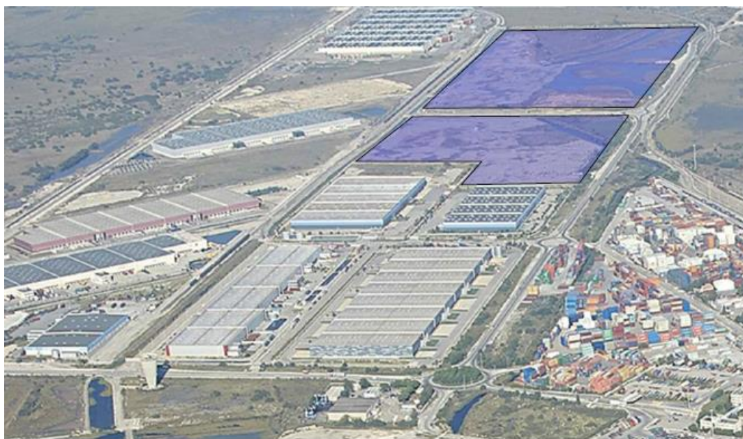
Vue aérienne de l'emplacement du projet
