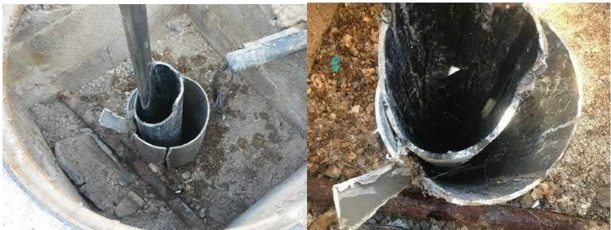
Figure 4 : Tête de forage
