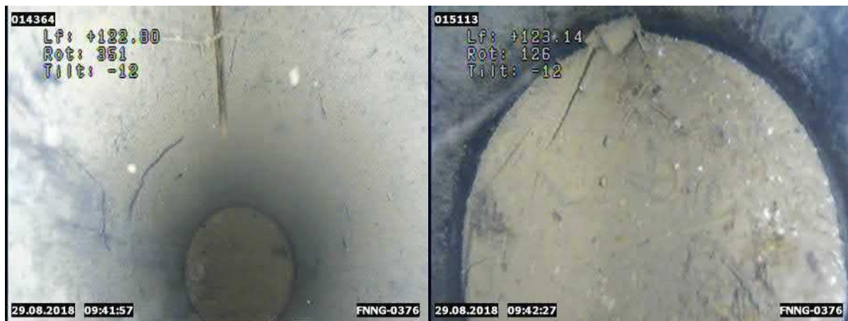
Figure 12 : Fond de l'ouvrage
