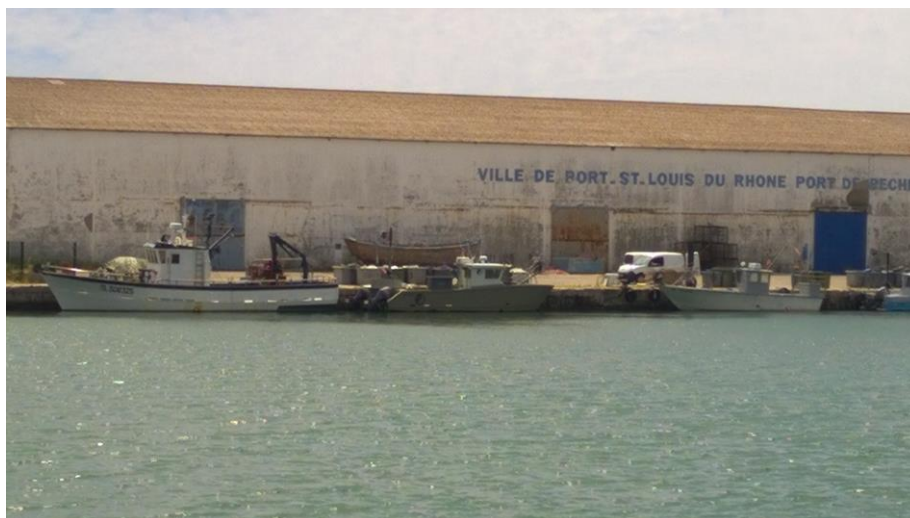
Figure 47 : Port de pêche des bassins de Saint-Louis : zone de débarquement de Port-Saint-Louis-du-Rhône (PNRC, 2017)
