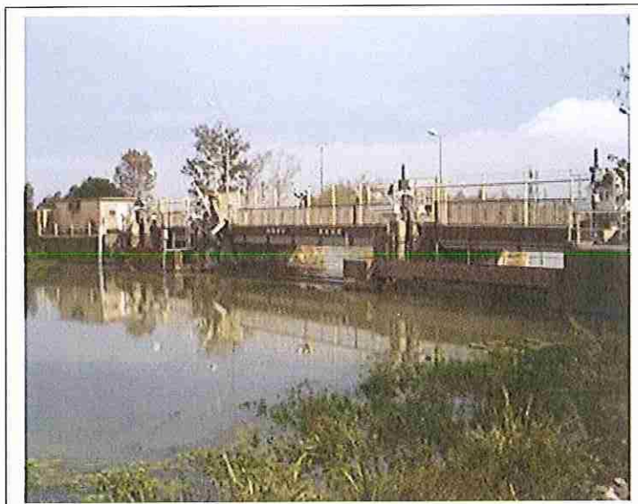
Barrage anti-sel vu de l'amont
