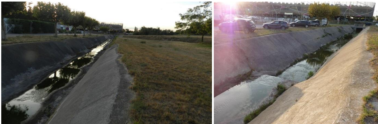
Fossé bétonné présent en limite sud de la zone d'étude, élément de continuité écologique
