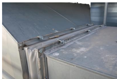
Bât F3 Gaine en textile picorée et souillée
