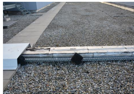
Bât F3 Calendrite arrachée à coups de bec
