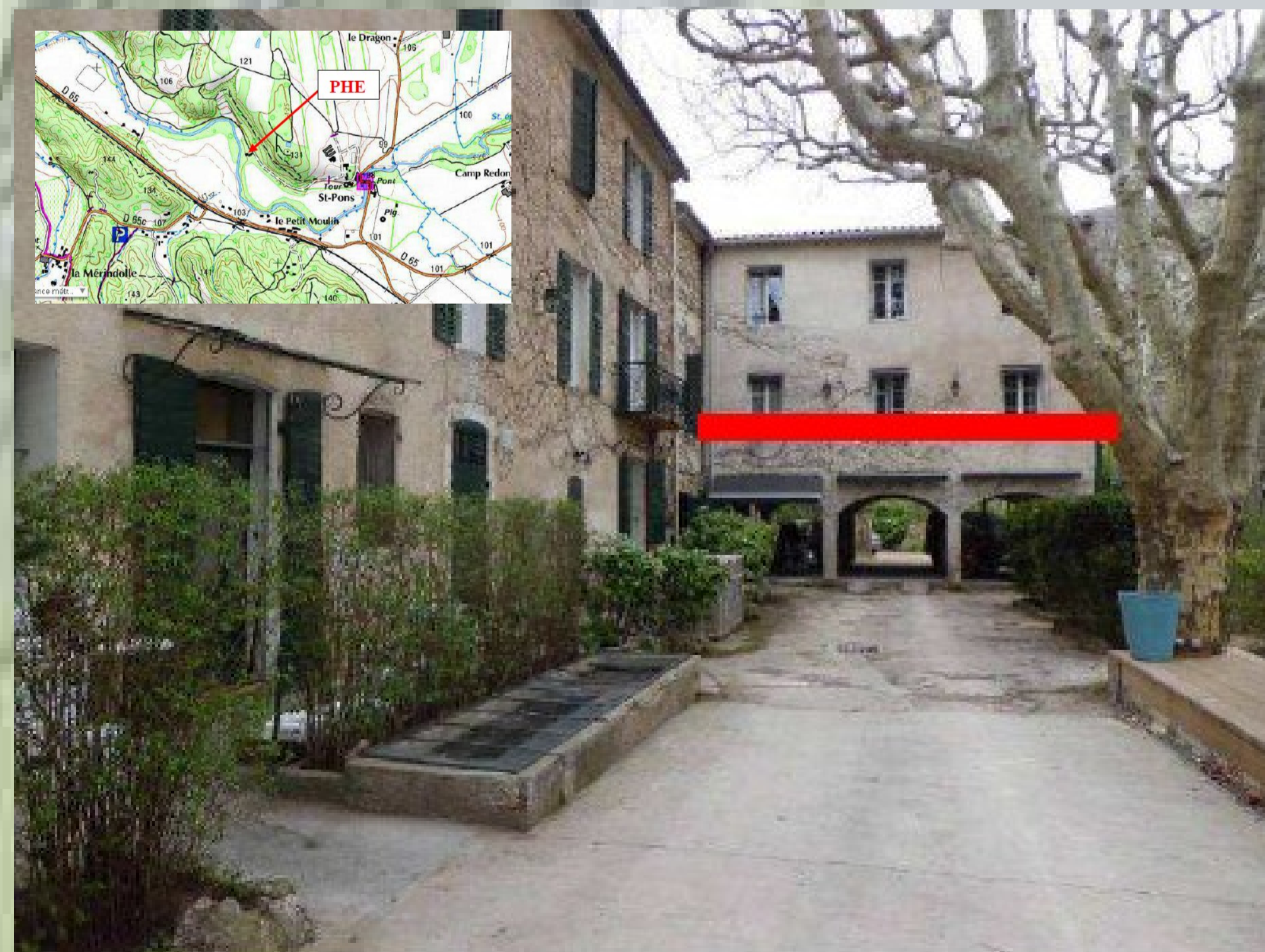
Hauteur d'eau atteinte à l'Hôtel des Arquiers pour les crues de 1978 et 1993
