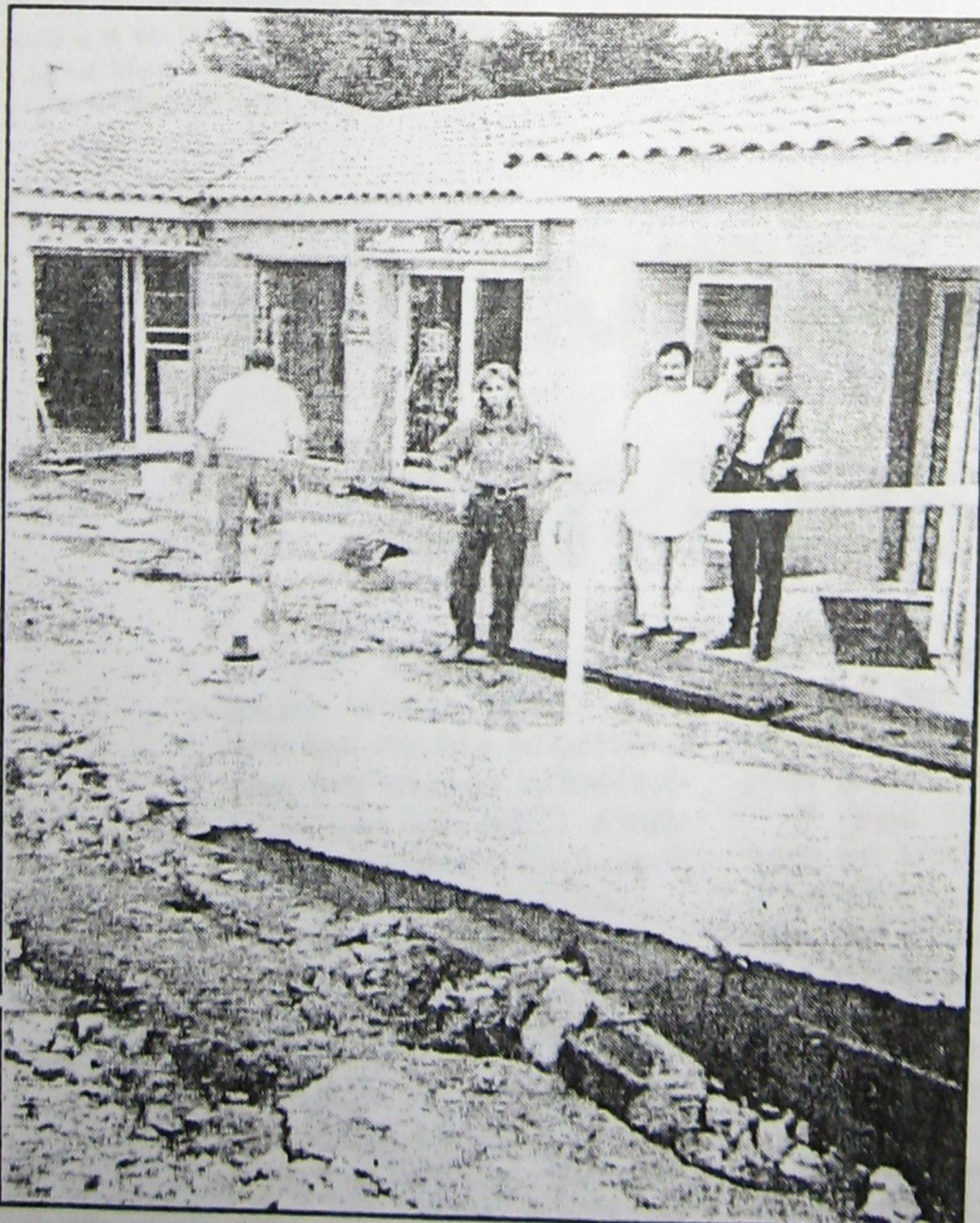
Du côté de la pharmacie et de la boulangerie, les dégâts ne sont pas trop importants. En revanche, c'est la route qui y mène qui a été malmenée (Photo D.O.)
