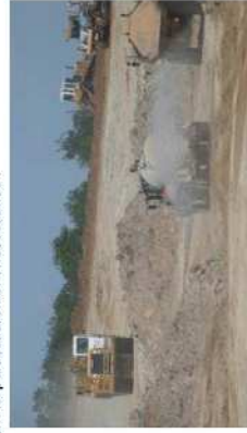
Arosage d'un chantier
