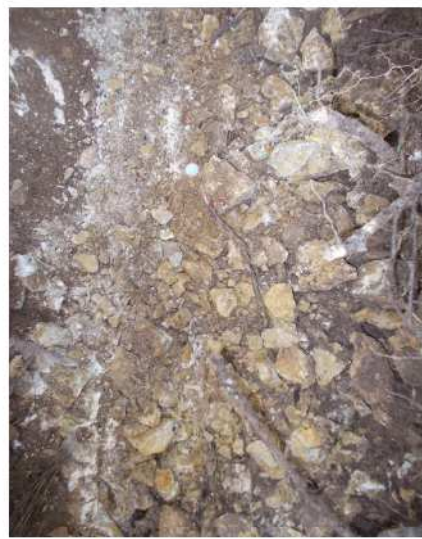
Vue du fond de fouille
