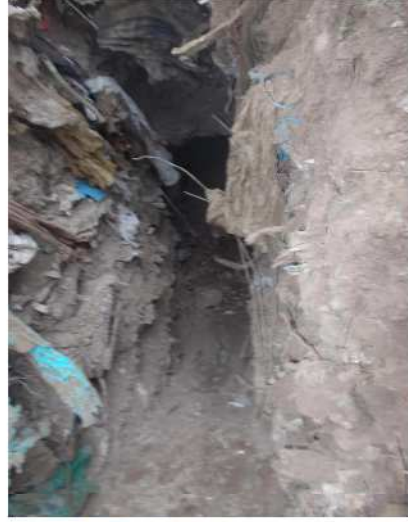
Vue du fond de fouille
