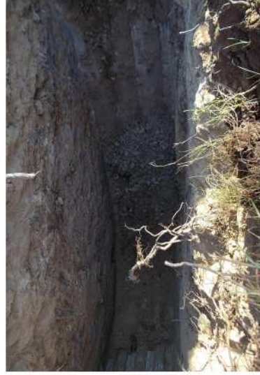
Vue du fond de fouille
