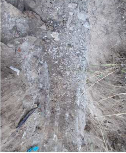
Vue du fond de fouille
