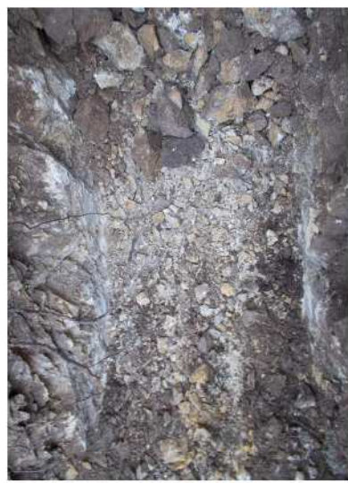
Vue du fond de fouille
