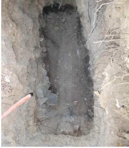
Vue du fond de fouille
