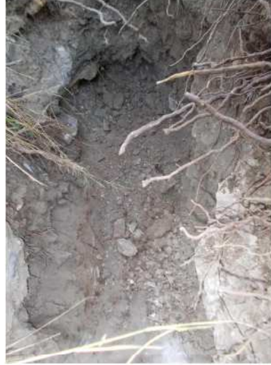
Vue du fond de fouille
