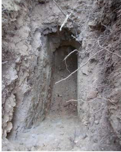
Vue du fond de fouille
