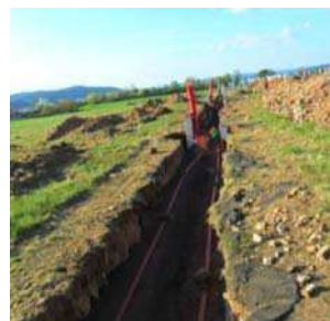
Photo 3 : Exemple de tranchée pour le câblage
