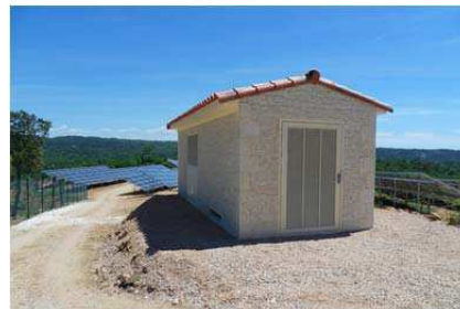
Photo 2 : Exemple de poste de livraison en pierre
