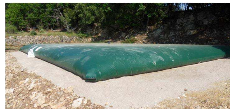
Photo 9 : Exemple de citerne souple de 120m 3 du parc solaire de Montmayon (Source : VOLTALIA)
