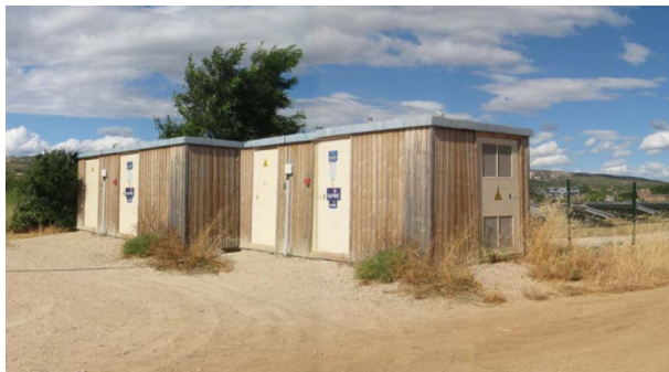
Figure 2 exemple de local technique
