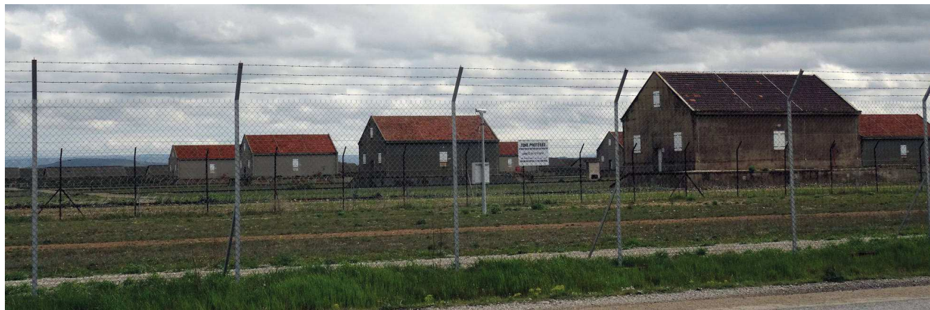
Vue 1 sur les igloos de stockage des munitions depuis la route RD10
