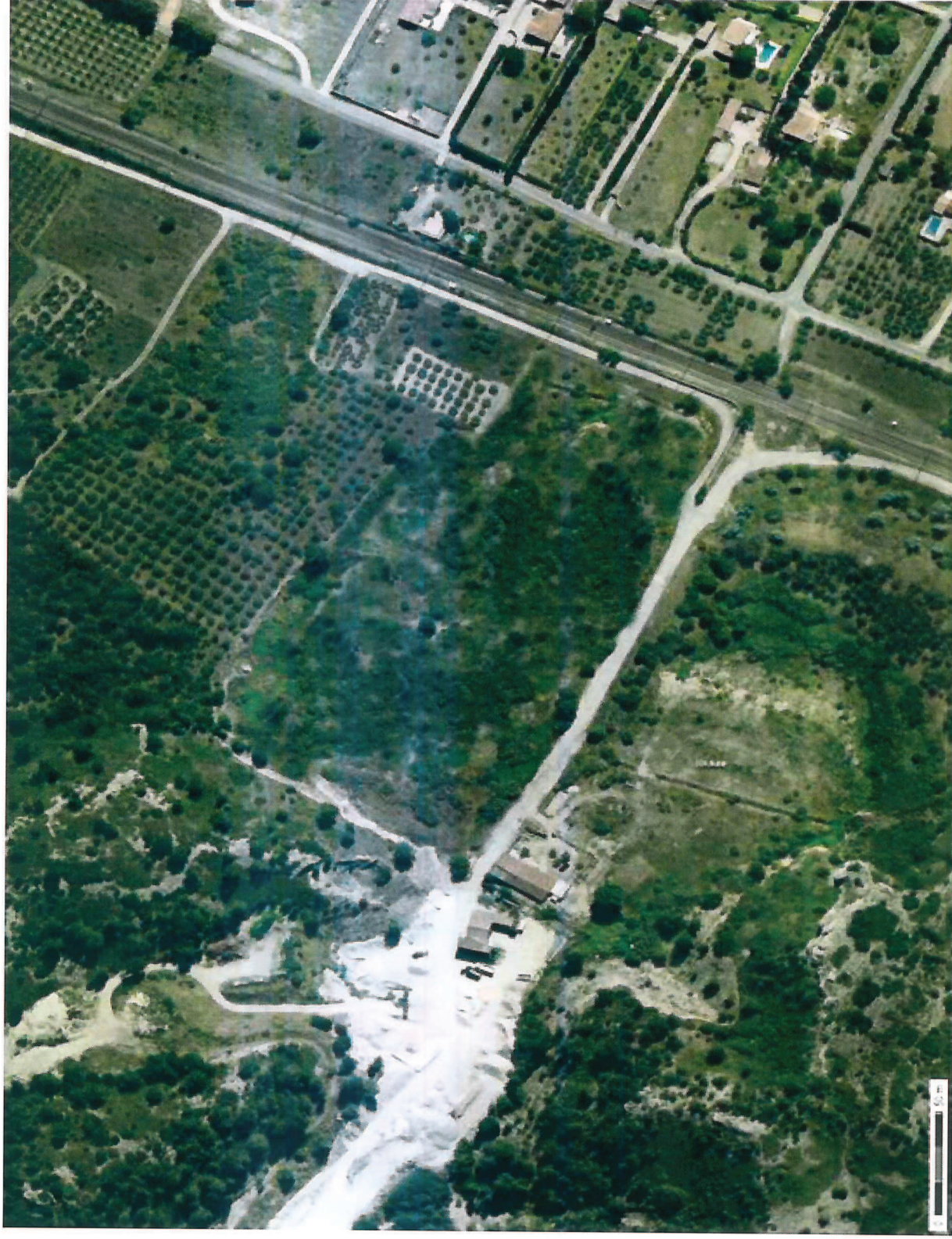
Vue aérienne de l'état final du site après remise en état
