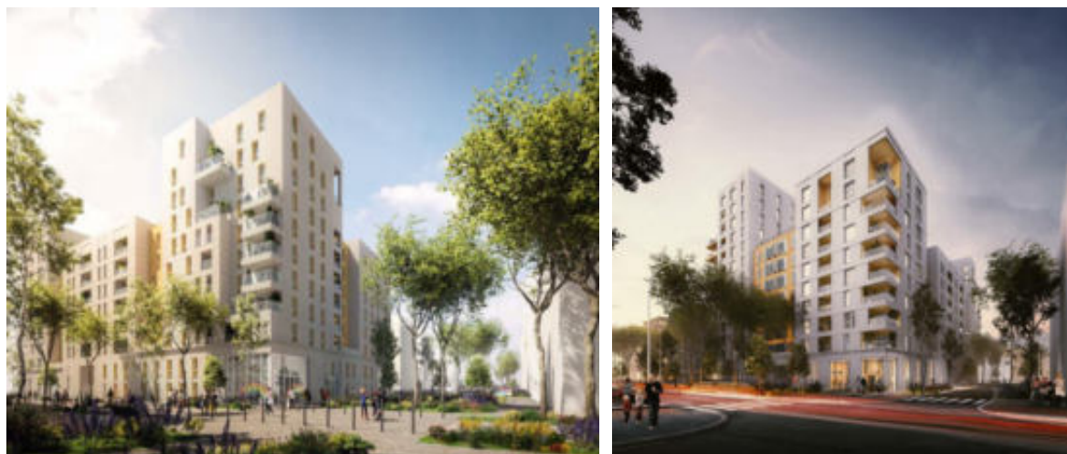
Figure 8 : Vue à l'angle des rues Jardin et de la Traverse de l'extension (à g) et vue à l'angle des rues Allar et de la Traverse de l'Extension (à dr) (source : Linkcity, 2019)
