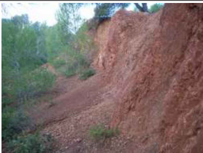
Travaux à ciel ouvert Manville Ouest TR3
