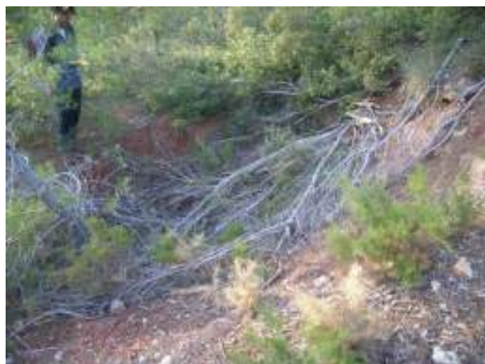
Effondrement localisé à l'est de la carrière de Mas Méjean D1
