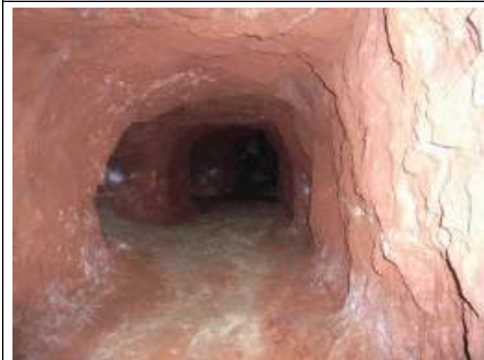
Réseau souterrain Viaud Ricaud (non Rondani)
