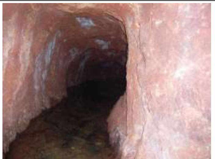
Réseau souterrain Viaud Ricaud (non Rondani)
