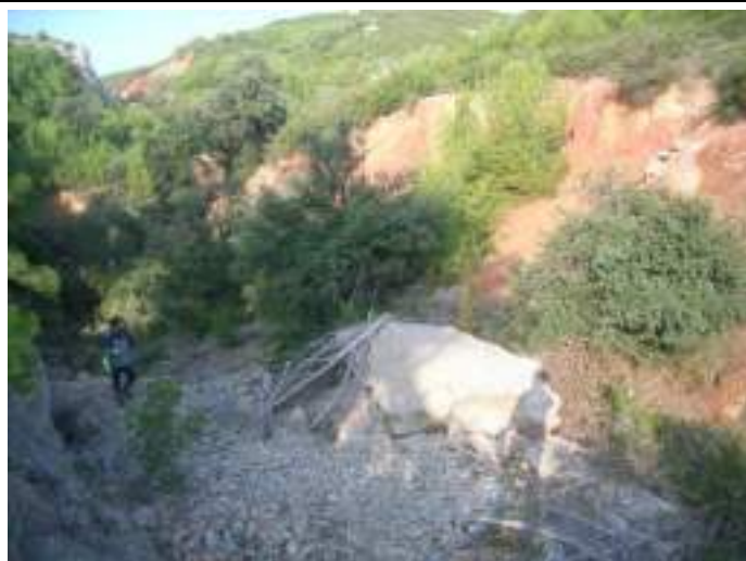
Autre tranchée Tr14 avec chutes de petits blocs
