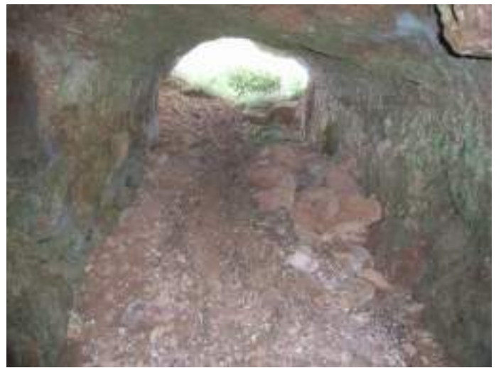
Vue intérieur de GGM6
