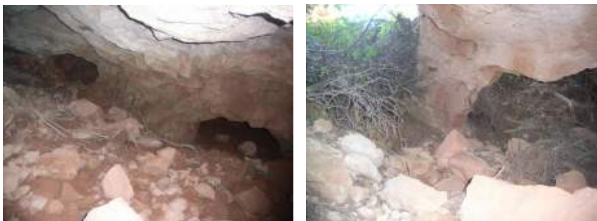
Figure 28 : piliers dégraissés dans des exploitations de configuration TMS1 (secteur d'Anna Mas et Fléchons), INERIS
