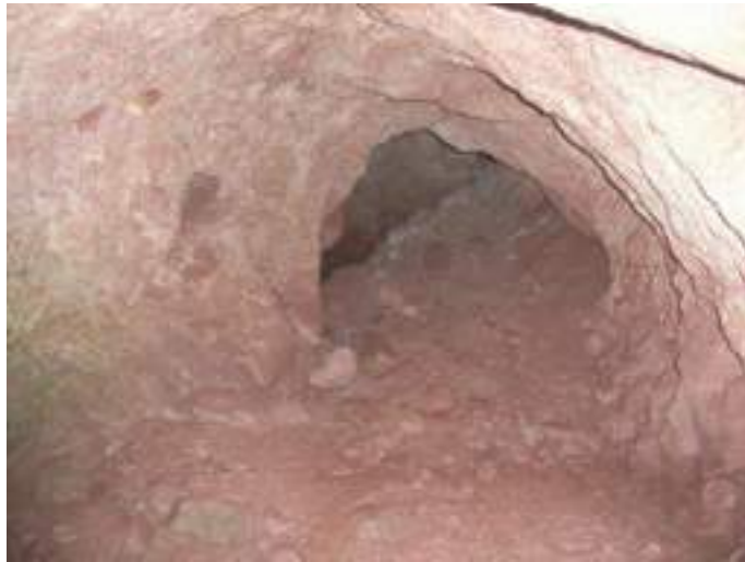
Vue intérieure de la galerie GAM2
