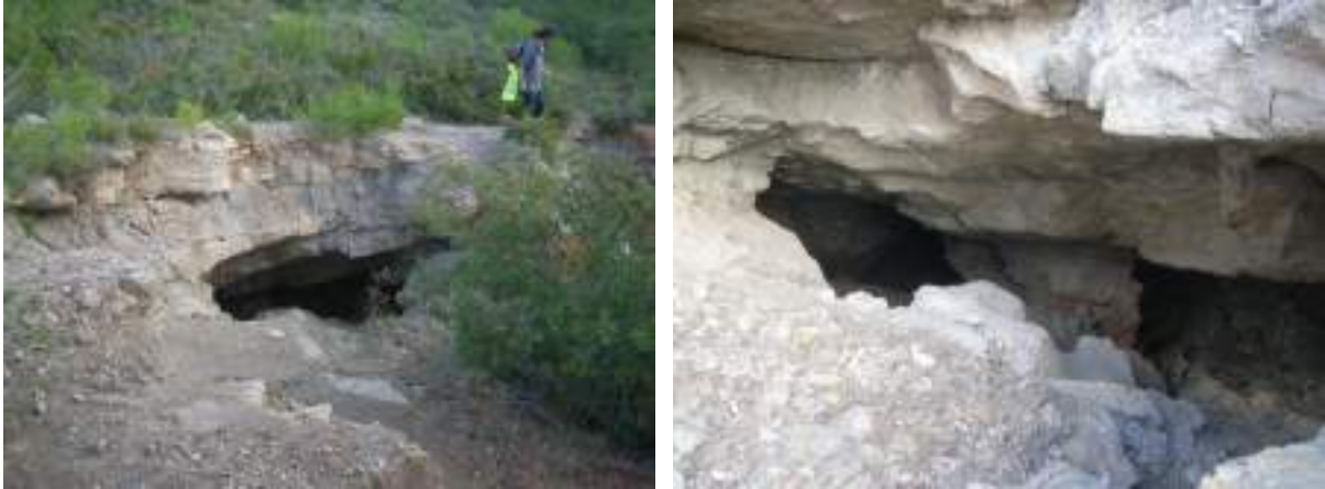
Figure 17 : effondrement localisé au droit de travaux dans le secteur de Manville Ouest, INERIS
