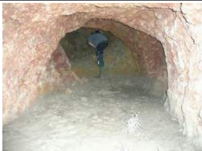
Vue intérieure Vue intérieure de la galerie GMO4
