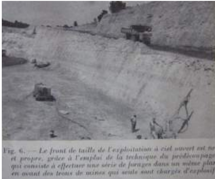
Figure 15 : fronts d'excavation aux Canonnettes dans les années 1970, [11]
