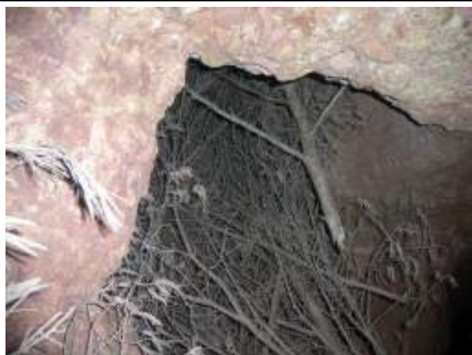
Vue intérieure de la galerie GMO2 et puits PMO2
