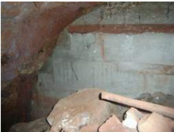
Intérieur descenderie GCa1 des Canonnettes (murée à 10 m)
