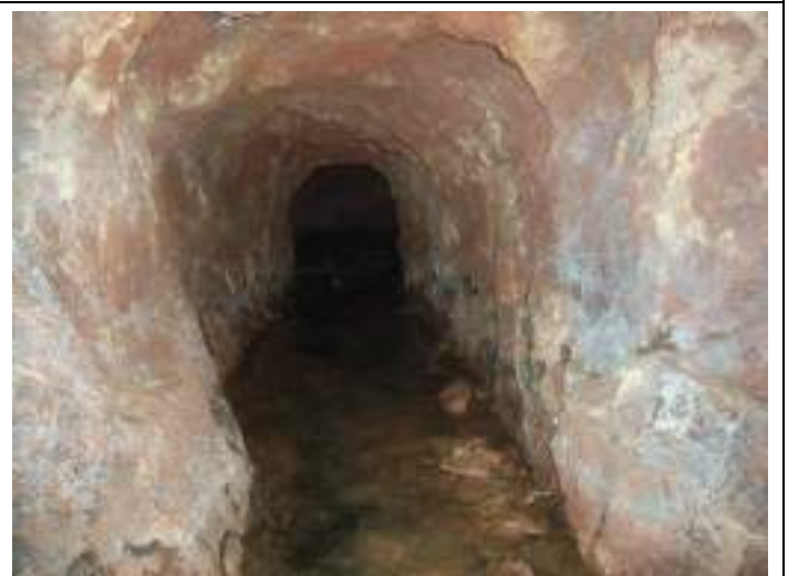
Réseau souterrain Viaud Ricaud (non Rondani)
