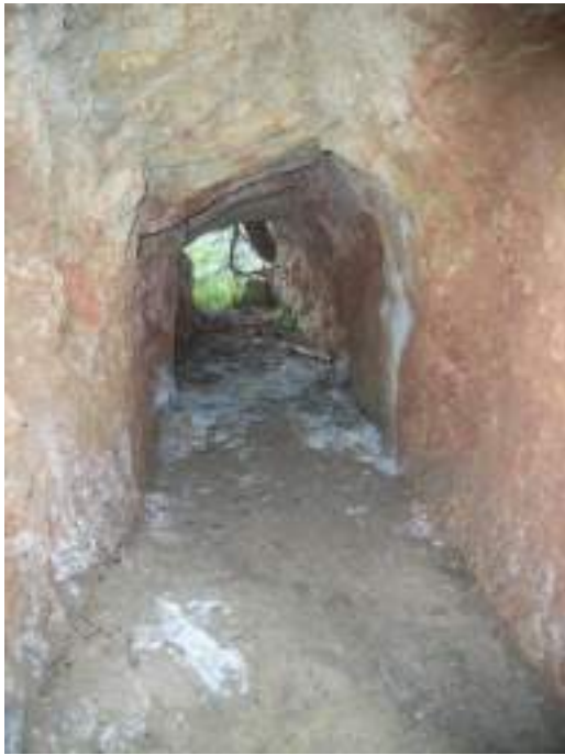
Vue intérieure de la galerie de recherche GMO5
