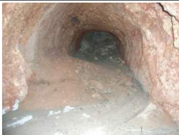
Vue intérieure de la galerie GMO4
