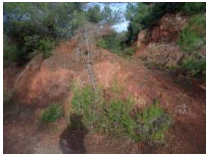
Tranchée/grattage Galerie à l'est de la grande MCO des Canonnettes Gr1
