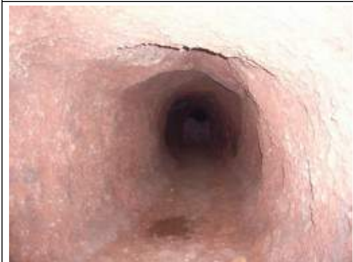
Réseau souterrain Viaud Ricaud (non Rondani)
