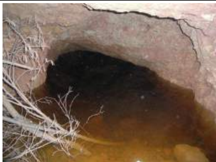
Vue intérieure de la galerie GMO2
