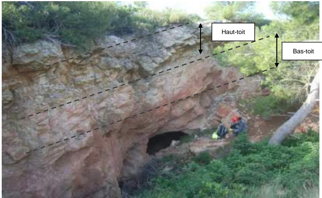
Figure 7 : bauxite exploitée, bas-toit de calcaires marneux et haut-toit de calcaires plus massifs. Secteur d'Anna Mas, INERIS
