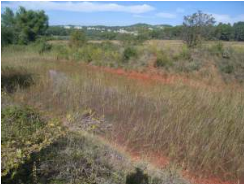
Figure 22 : un des bassins de décantation des Canonnettes en eau, INERIS
