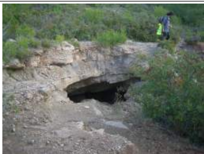
Effondrement localisé D4 donnant accès à une petite zone exploitée au bout de la galerie GMO4
