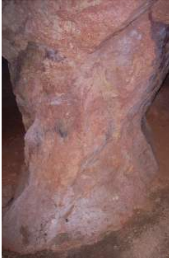
Figure 33 : pilier « fragilisé », secteur de Mas Méjean, INERIS
