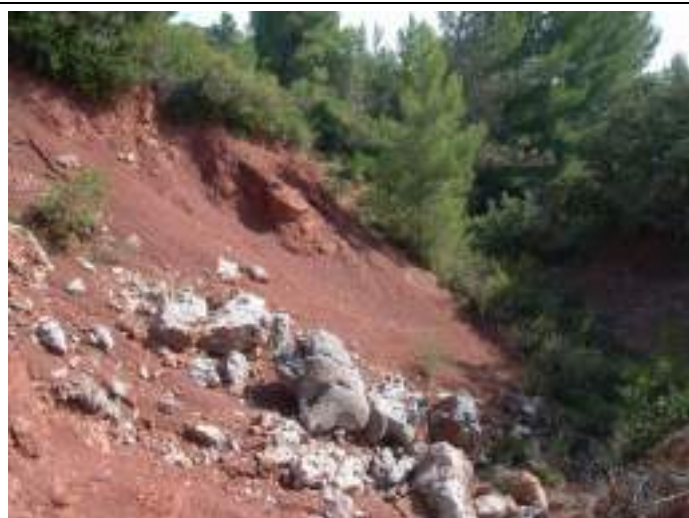
Travaux à ciel ouvert à l'extrémité ouest du secteur (Tr4)
