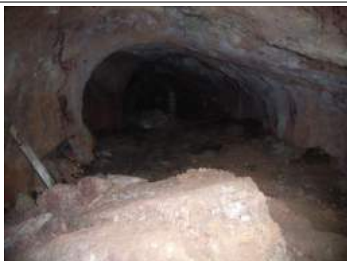
Chambres et piliers au pendage de la carrière souterraine de Mas Méjean
