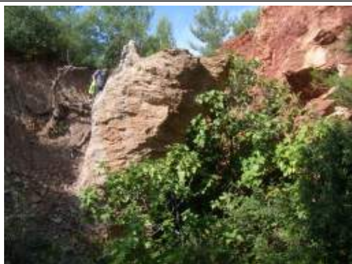
Travaux à ciel ouvert à l'extrémité ouest du secteur de Grand Méjean (Tr4)
