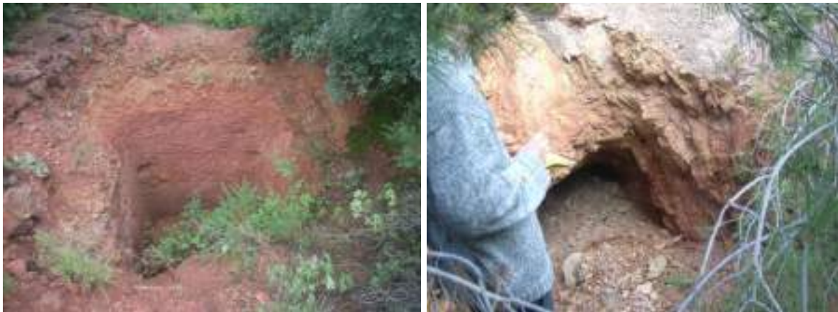
Figure 18 : épontes altérées d'ouvrages miniers creusés dans la bauxite, INERIS
