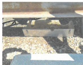
Nid de Goéland caché sous organe de ventilation
