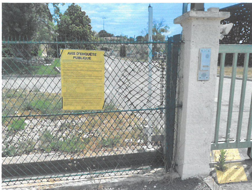
Affichage à l'entrée de la station d'épuration de Rassuen (affiche visible de la D52)
