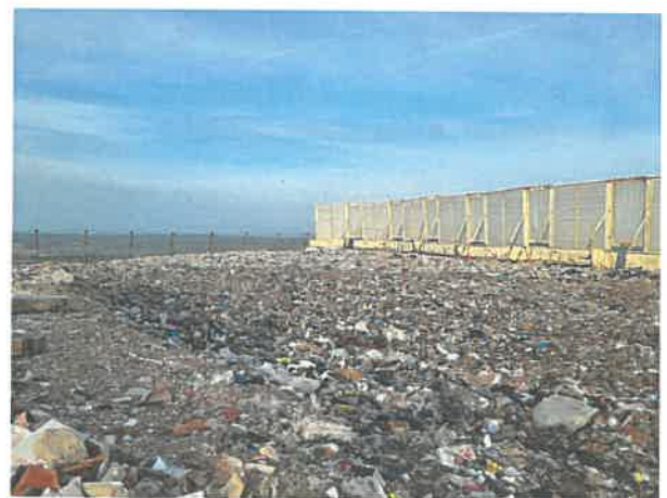
Compactage des déchets en bandes avant la mise en place de la couverture
