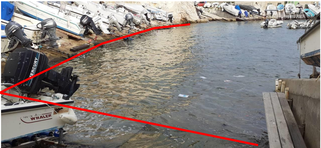
Vues de la partie du glacis à réhabiliter
